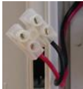
Рисунок 9. Кабель для подключения замка к блоку питания
